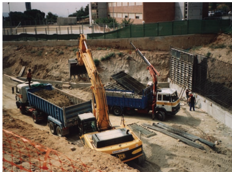
Estiu del 2003. Les obres dels terrenys de Can Caralleu, en fase de fonamentació
